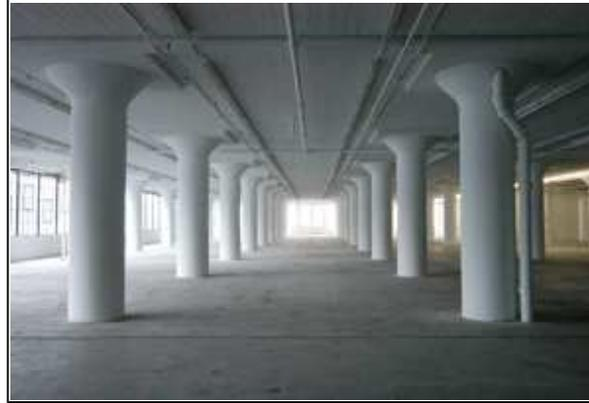
Figure 8: Dalle en béton armé
