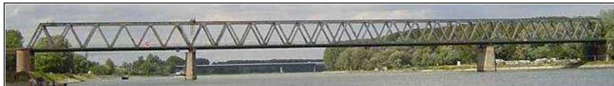
Figure 3: Pont en treillis métallique continue sur trois travées (Germersheim, Allemagne)
